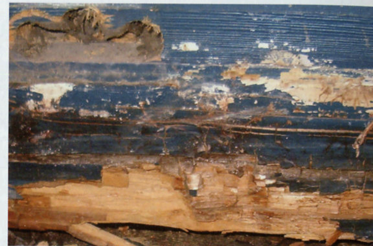
La pièce de bois attaquée par le méréle se désagrége sous la forme d'une « pourriture cubique » caractéristique.
